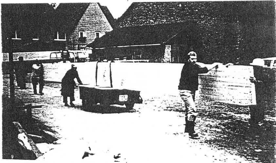
Die Dachträger werden geliefert
