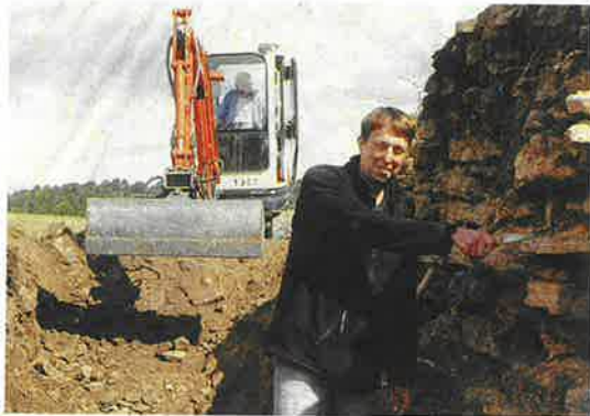
Das Foto zeigt den Beginn der Arbeiten an der Holsterburg. (Privatfoto)
