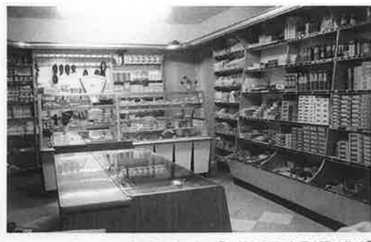
Blick in den Geschäftsraum nach dem Umbau 1961
