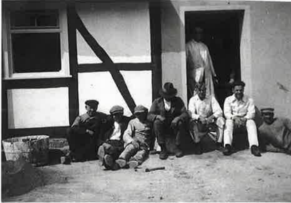
Bild 2: Arbeiter die den Umbau des Hauses ausgeführt haben.
