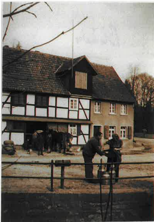
Bild 3 Ein Teil der wichtigen Arbeiten fanden vor der Schmiede auf der öffentlichen Straße statt.
