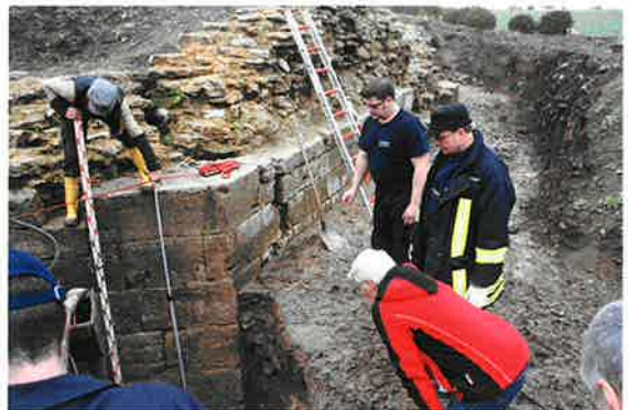
Nach Abpumpen des Wasser trat ein dreifach gegliedertes Fundament zu Tage. Bedeutsam für die Beurteilung sind die exakt behauenen Steine
