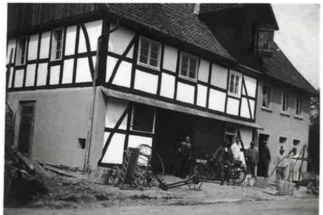
Bild 1: Die Schmiede vor dem Umbau
