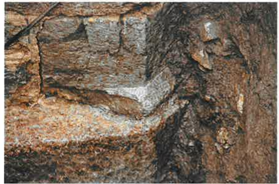
Nach Abpumpen des Wasser trat ein dreifach gegliedertes Fundament zu Tage. Bedeutsam für die Beurteilung sind die exakt behauenen Steine
