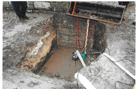
Auf der Grabungssohle sehen wir ein die Kreiselpumpe, die das Wasser aus der Ausgrabungsgrube pumpt.
