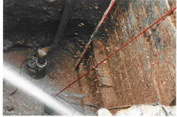
Auf der Grabungssohle sehen wir ein die Kreiselpumpe, die das Wasser aus der Ausgrabungsgrube pumpt.
