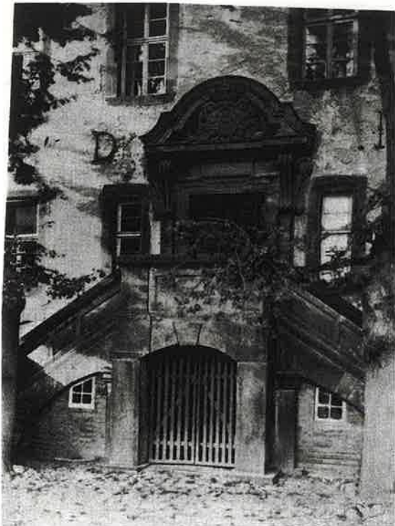
Portal der Südfront; Aufnahme Reinking 1927.
